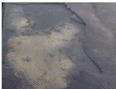
Ist das Dach nun einige Zeit der Witterung ausgesetzt werden die Risse größer und es brechen Teile der obersten Schicht des Daches heraus.
