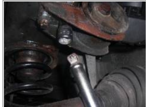
Tausch des hinteren Motorlagers
